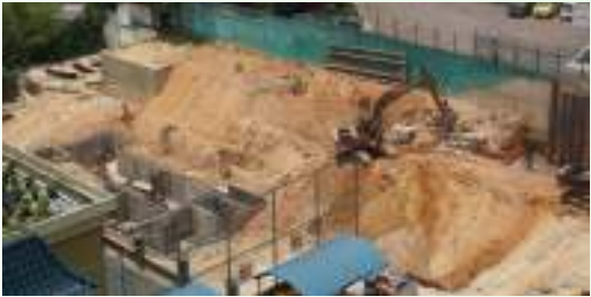
打桩及地下工程
